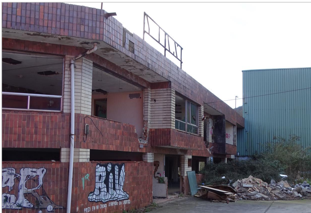
Foto 8. Gran parte del ámbito BIZ-11-Fytasa se encuentra ocupado por antiguas instalaciones industriales.
