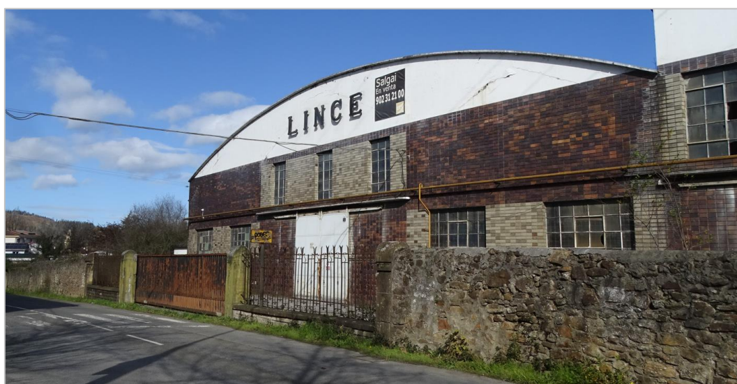
Foto 22. Pabellón industrial obsoleto en el ámbito JE-09 San Bizente-Zabaleta II.
