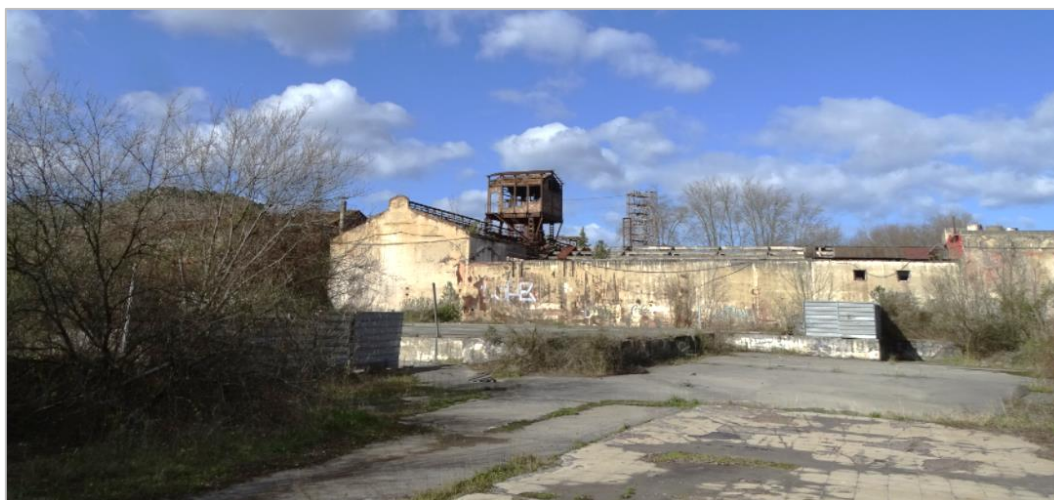
Foto 16. Instalaciones industriales obsoletas en el ámbito JE-02 Forjas
