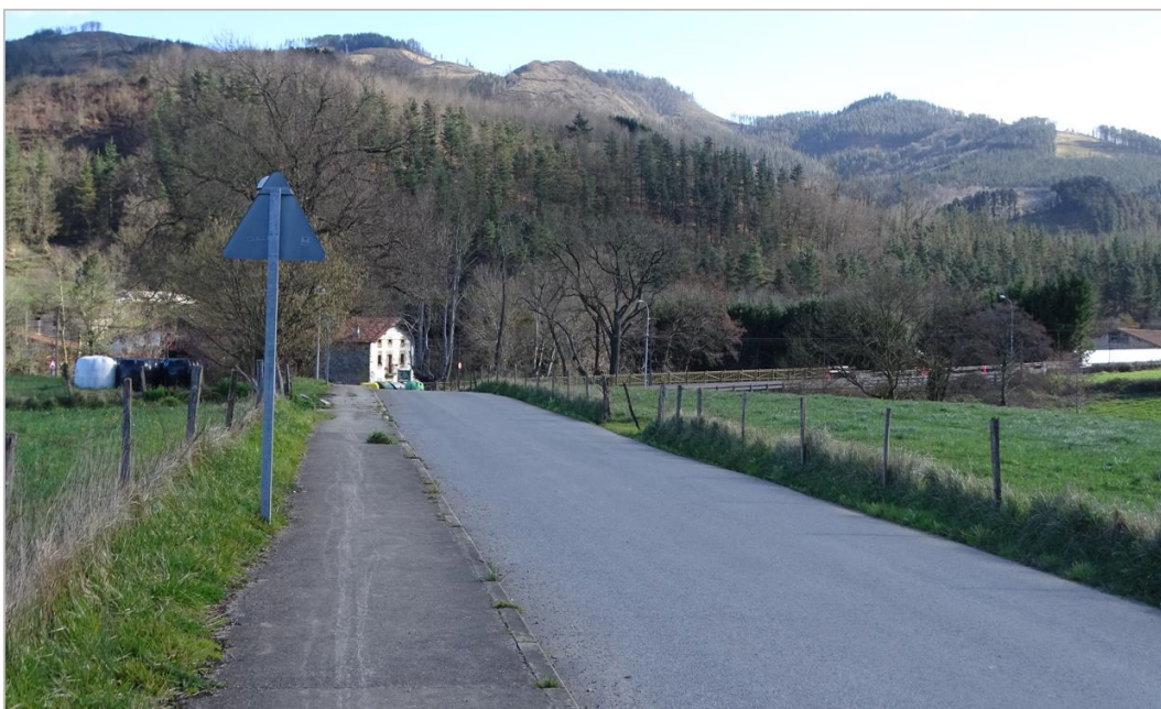
Foto 26. Actual vía por la que se propone la actuación MUG-09 en el ámbito de actividades económicas JE-01 Pulla Azkarreta. Junto al caserío que se observa al final se proyecta una rotonda para conectar con la BI-3331 (travesía de Elorrio).
