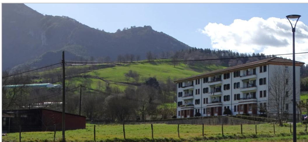
Foto 1. Los prados frente al edificio de viviendas del sector San Anton Barria se propone para su desclasificación.
