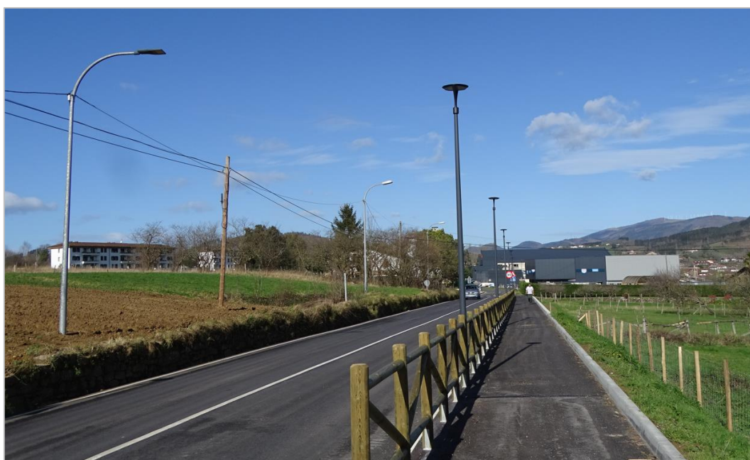
Foto 27. El eje de movilidad saludable se encuentra actualmente en desarrollo en la zona este
